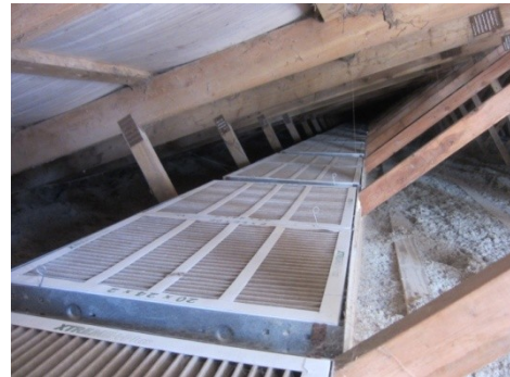
WTF 豚舎の間口にある階段(フィルターのメンテナンスのため)右は屋根裏のフィルター
