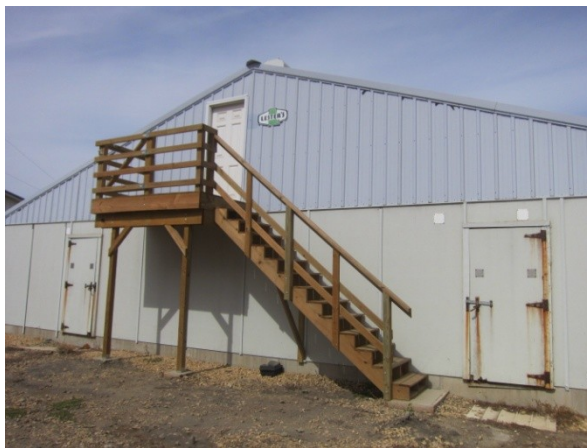
WTF 豚舎の間口にある階段(フィルターのメンテナンスのため)右は屋根裏のフィルター
