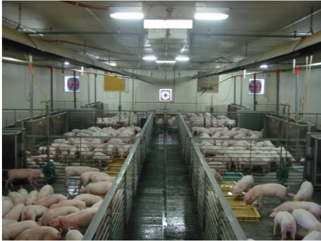
ラジエントと排気ファンがある一般的な環境制御型離乳舎の様子
